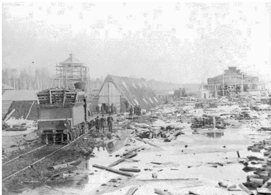
Паровозный барак, строящиеся 1-я водонапорная башня и депо ст. Тайга 1
